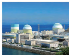
原子力発電所
